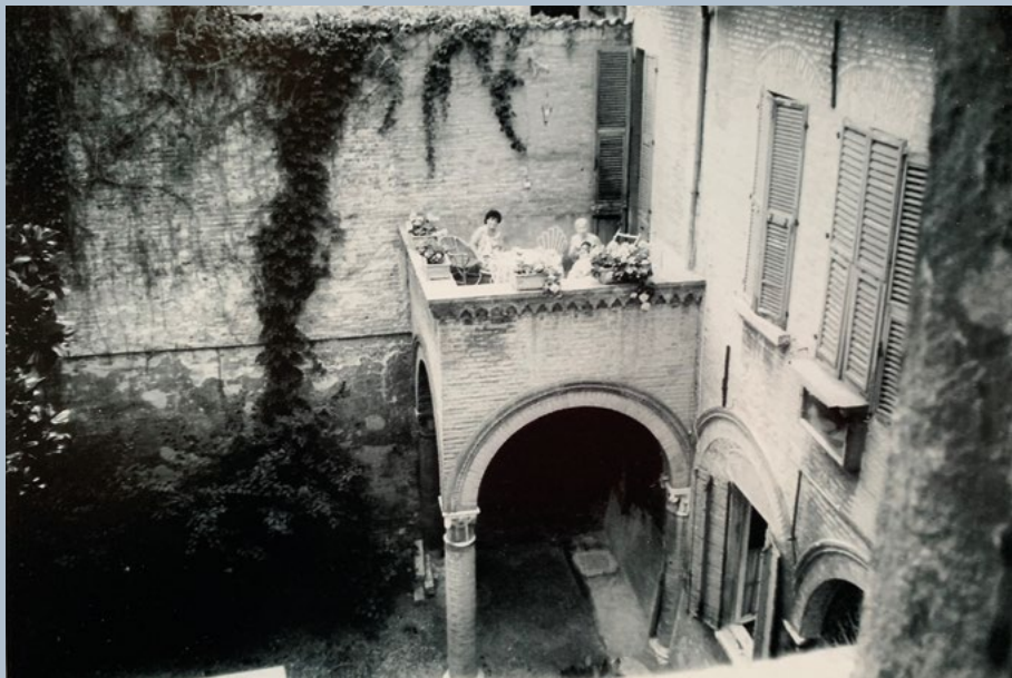
Casa Bassani: veduta sul giardino interno
